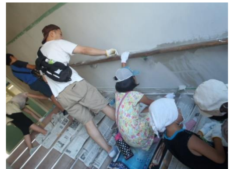
【階段壁面ペンキ塗り】 ↑
